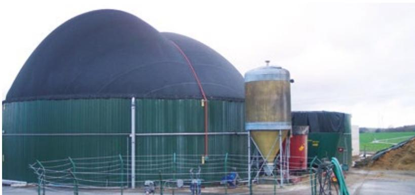
*Abb.: Sturmschaden an einer Biogasanlage nach Orkan Kyrill: Die Folienhaube des rechten Fermenters wurde zerstört. Beim vorderen Fermenter konnte die Folienhaube erfolgreich mit einem Spanngurt gesichert werden.*
