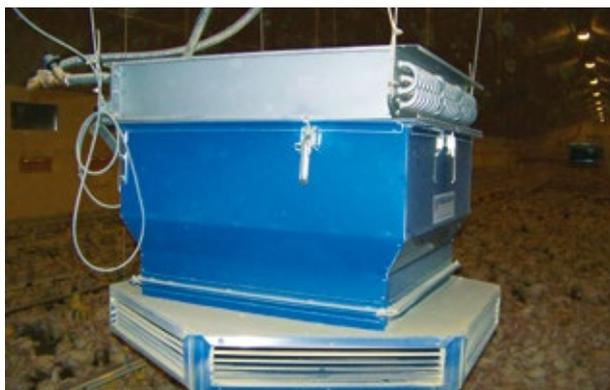
Abb.: Heizung mit Warmwasserkonvektor in einem Geflügelstall
