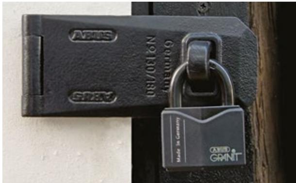
Abb.: Guter Verschluss mit schwerem Hangschloss und Überfalle.
