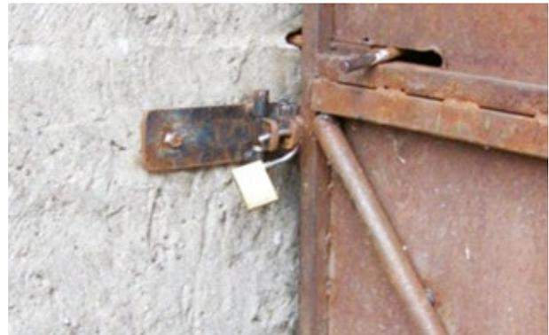
Abb.: Kleine Messinghangschlösser aus dem Baumarkt sind für Türsicherungen völlig ungeeignet.
